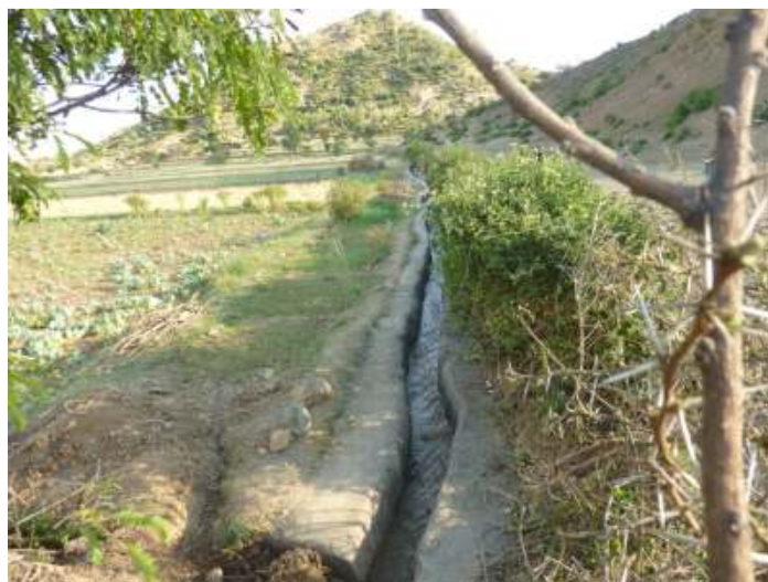
In Bete Yohannes haben die Bauern aus eigenen Mitteln den Kanal vom Damm zu den Gemüsefeldern verlängert und betoniert. So können sie 20 ha mehr Gemüse anbauen. Bete Yohannes, Adwa, Tigray, November 2012
