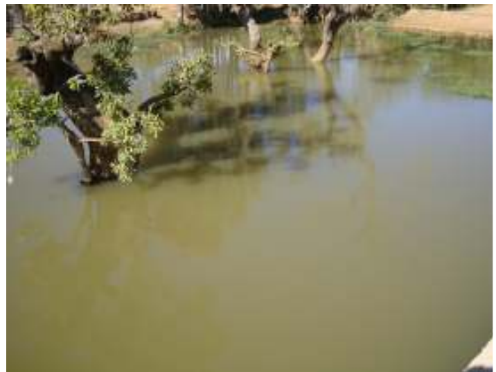
Und das Rückstauvermögen des Dammes ist sehr gross. Weit zurück im Flussbett staut sich das Wasser. Nachdem es seit bereits 4,5 Monaten nicht mehr geregnet hat, sind alle – auch die Einheimischen – hoch erfreut und überrascht über die noch verbleibende Wassermenge.
