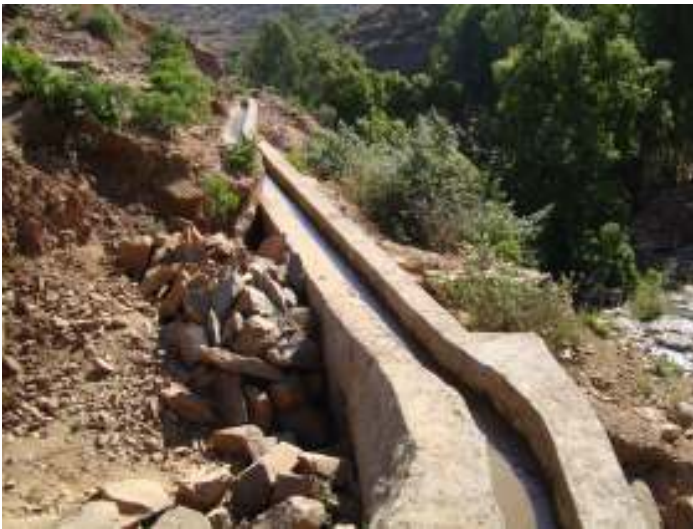
Über mehr als 200 m windet sich der Kanal (siehe fließendes Wasser in ihm) dem Hügel entlang zu den Feldern.
